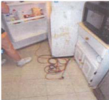
Extension cord used in lieu of permanent wiring:
