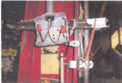
Extension cord used in lieu of permanent wiring:
